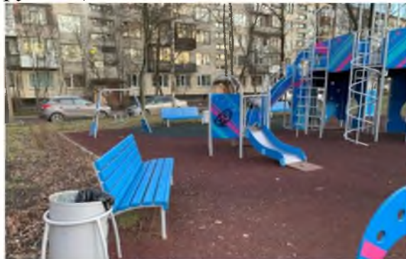
На фото: детская площадка в МО «Георгиевский» работы выполнены с нарушениями условий контракта
