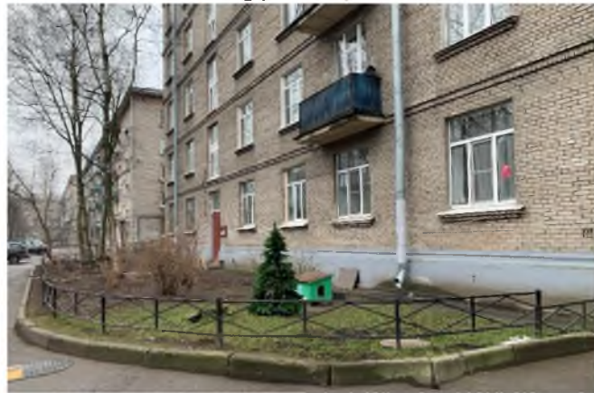
На фото: работы по благоустройству в МО Автovo
