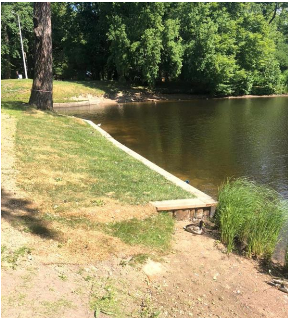
На фото: берегоукрепительные работы
