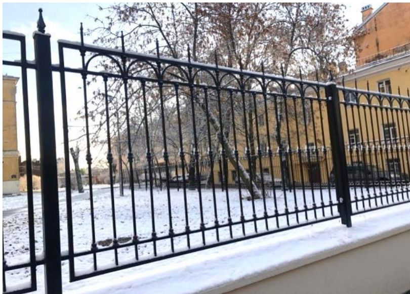
На фото: ремонт ограды ГБНОУ "Балтийский берег"
