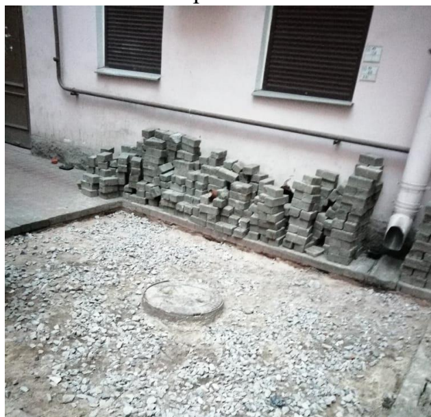
На фото: капитальный ремонт на территории объекта культурного наследия
