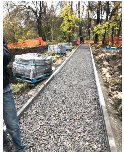
На фото: устройство новой пешеходной дорожки на ул.Бухарестская, д.33, к.2
