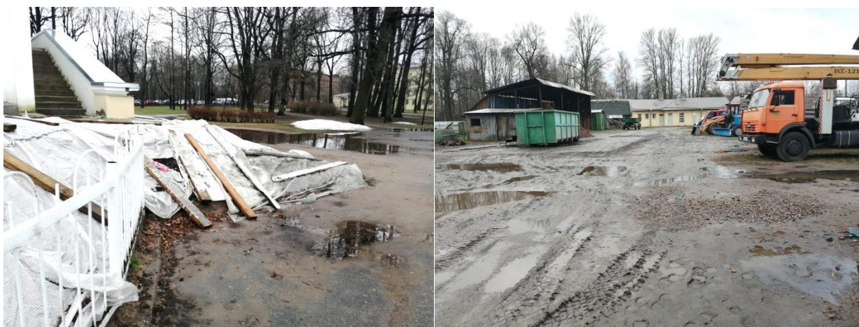
На фото: незавершенные работы на территории ГКУ «Парк «Екатерингоф»
