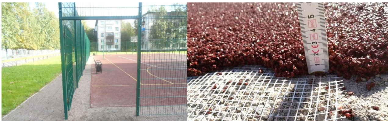
На фото: спортивная площадка с набивным покрытием на ул. Тельмана, 32
