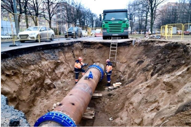
На фото: производство работ по модернизации магистрали
