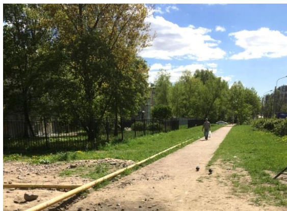
На фото: устройство новой пешеходной дорожки ул. Замшина, д.15
